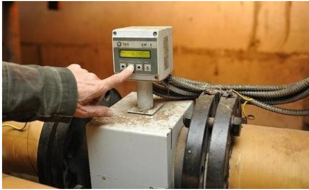
Рис. Б.4. Тепловий лічильник
