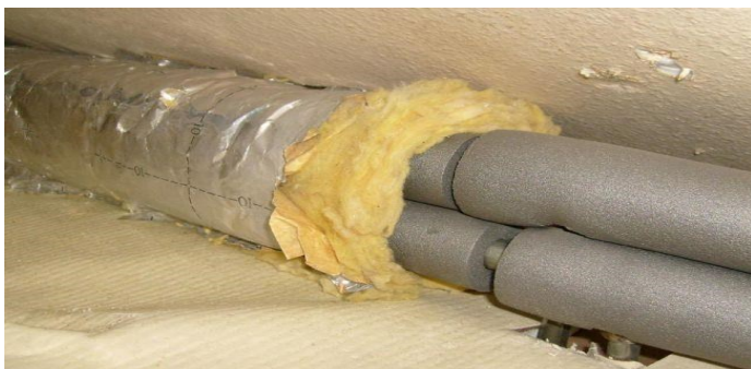
Рис. Г.1. Утеплені труби
